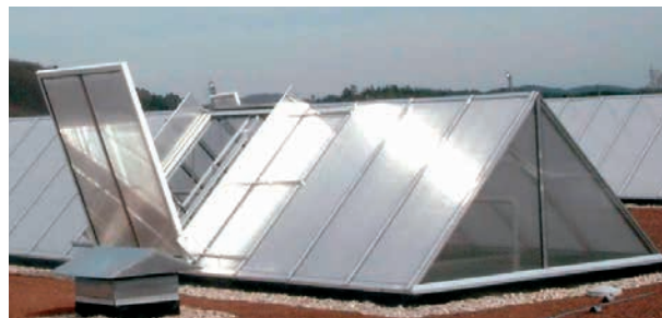
Systém samostatných klapek (EKS) VARIO-FIREJET® 65° pro EKS-TH 65° otevírací, instalovaný do sedlového pásového světlíku VARIO-THERM-S
