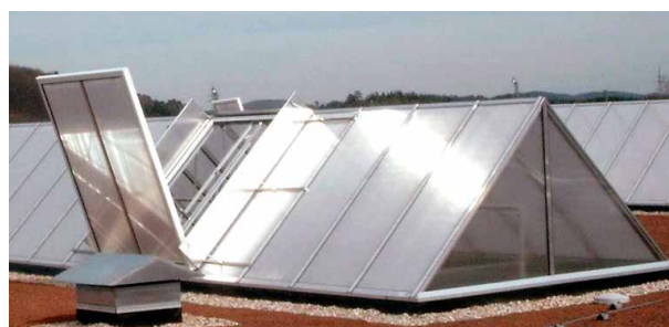
Systém samostatných klapek (EKS) VARIO-FIREJET® 65° pro EKS-TH 65° otevírací, instalovaný do sedlového pásového světlíku VARIO-THERM-S
