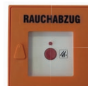
SHEV DIN secondary switch
