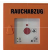
SHEV DIN main release switch
